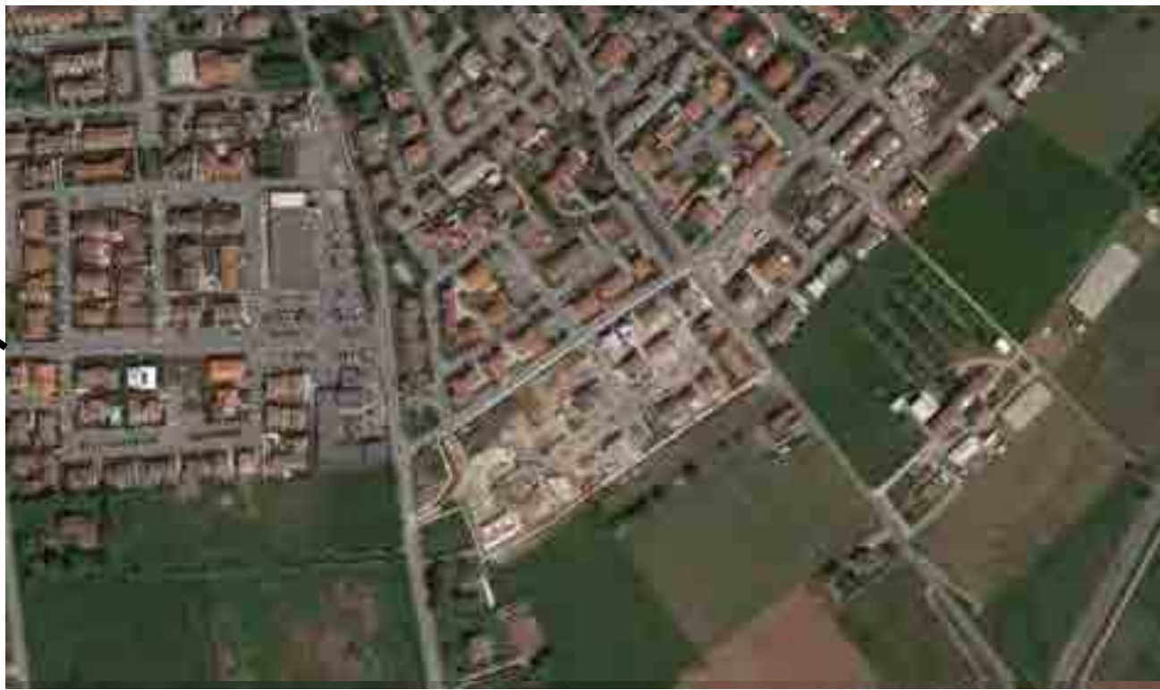
Nuovi edifici residenziali a Valeggio sul Mincio (VR)
